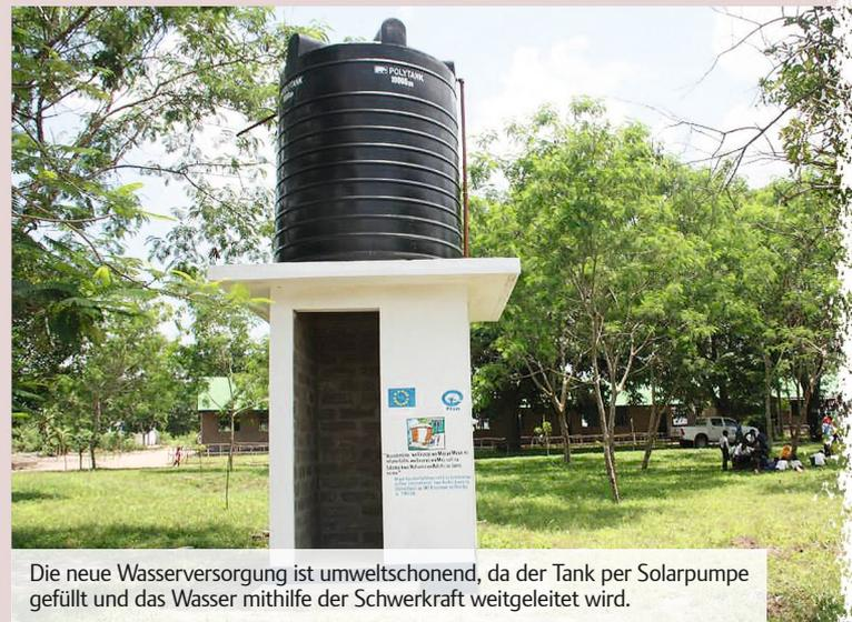
Die neue Wasserversorgung ist umweltschonend, da der Tank per Solarpumpe gefüllt und das Wasser mithilfe der Schwerkraft weitgeleitet wird.
